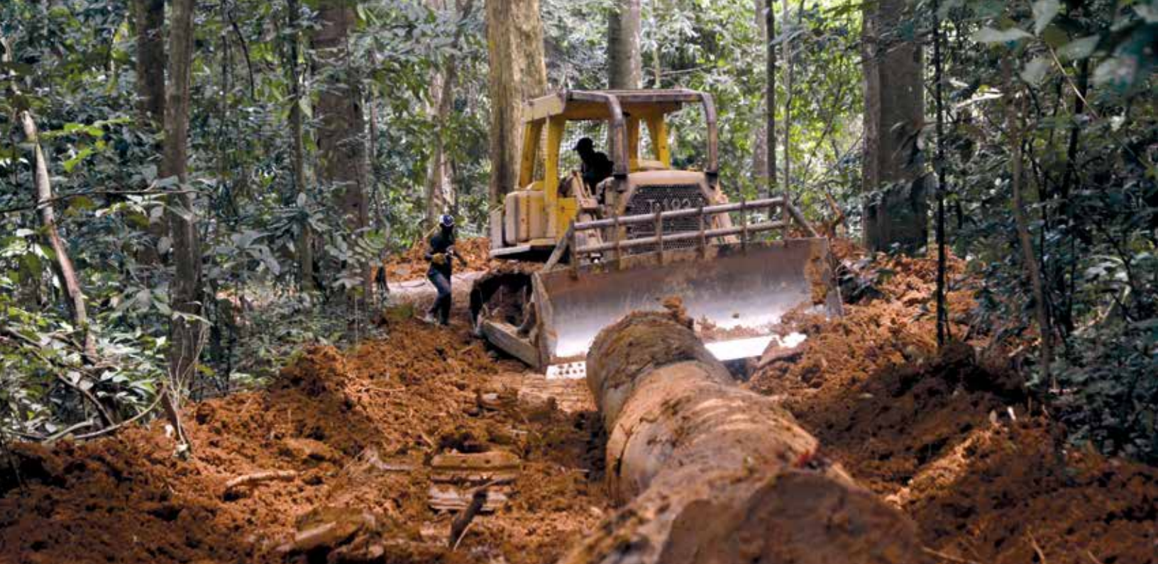
Un bulldozer ouvrant une piste forestière secondaire dans une concession au Gabon. Source: ANPN
