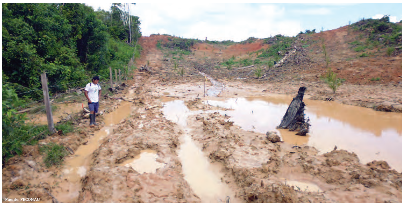
Imagen 16 Suelo erosionado y compactado por el uso de maquinaria en el Fundo Tibecocha
